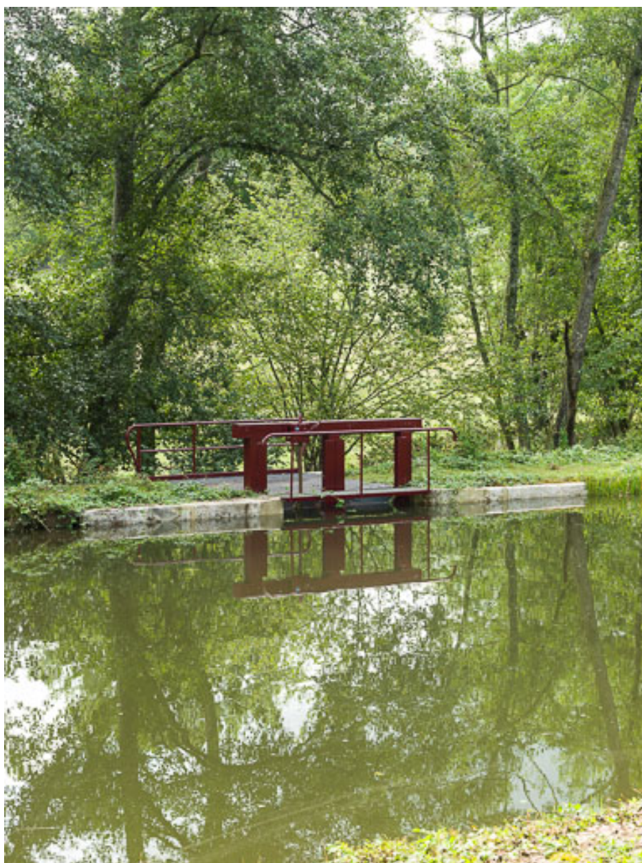
Vue du déversoir.
