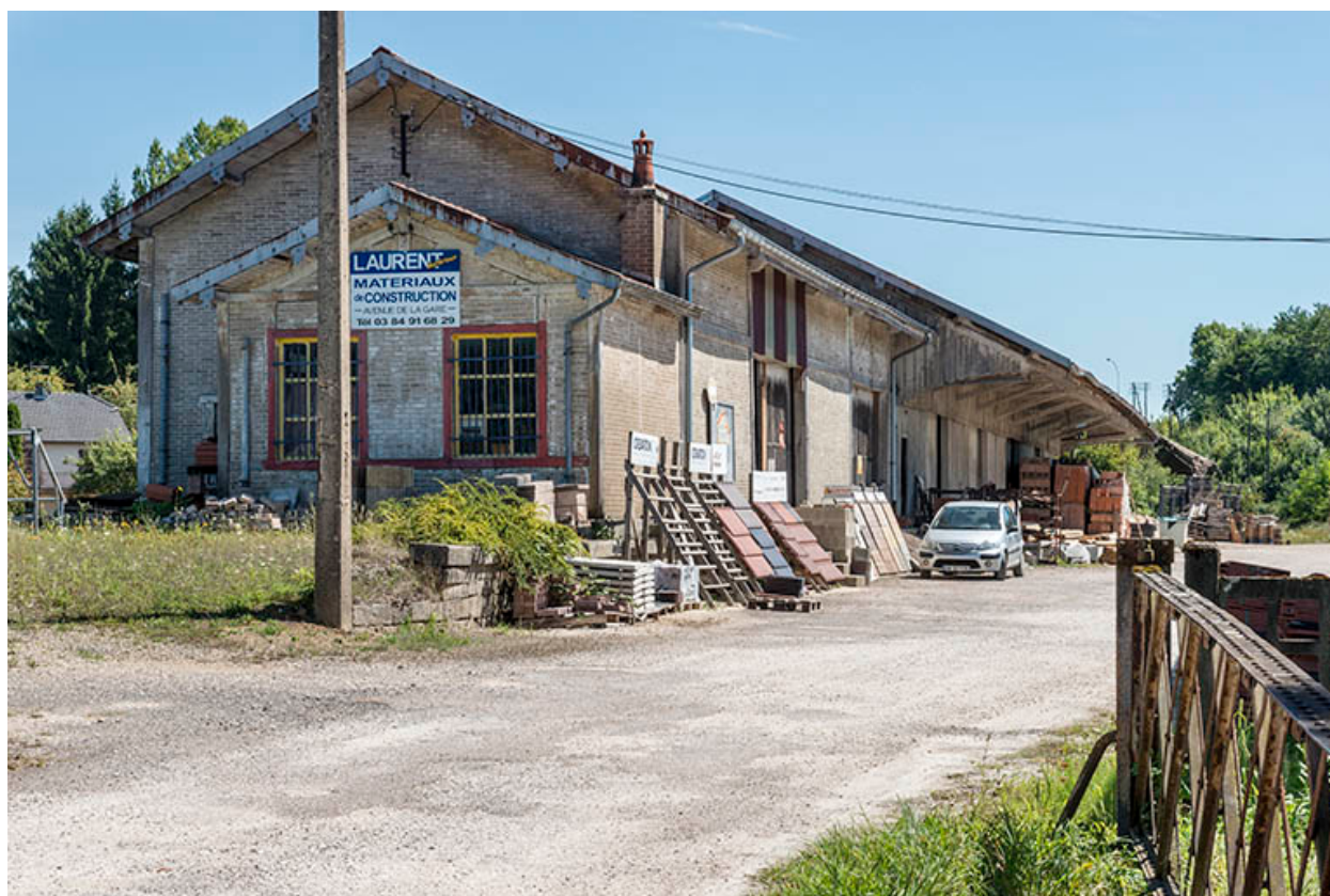
Vue depuis l'ancienne cour de la gare.
