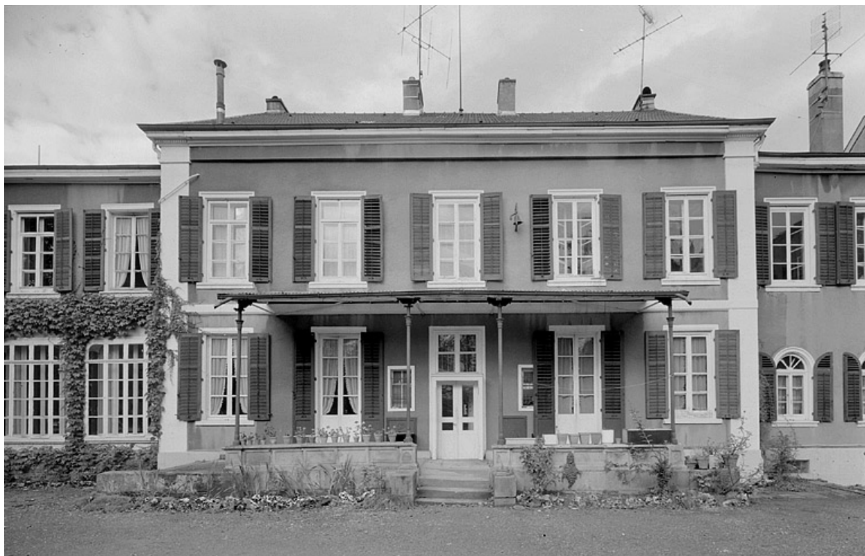
Façade sur jardin. Partie centrale.
