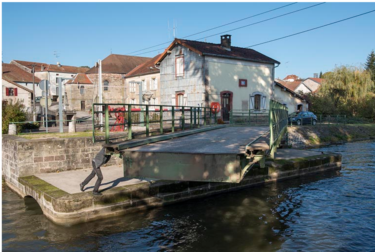
Rotation du tablier métallique.
