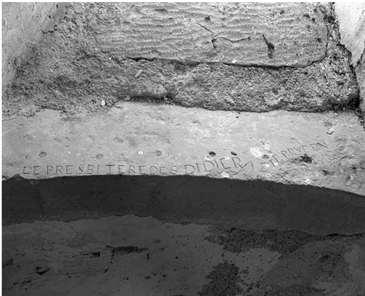
Fenêtre gauche de l'abside, graffitis de l'appui.
