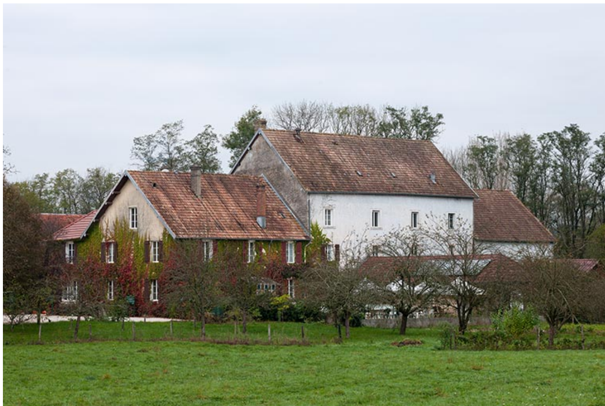
Vue depuis le sud.
