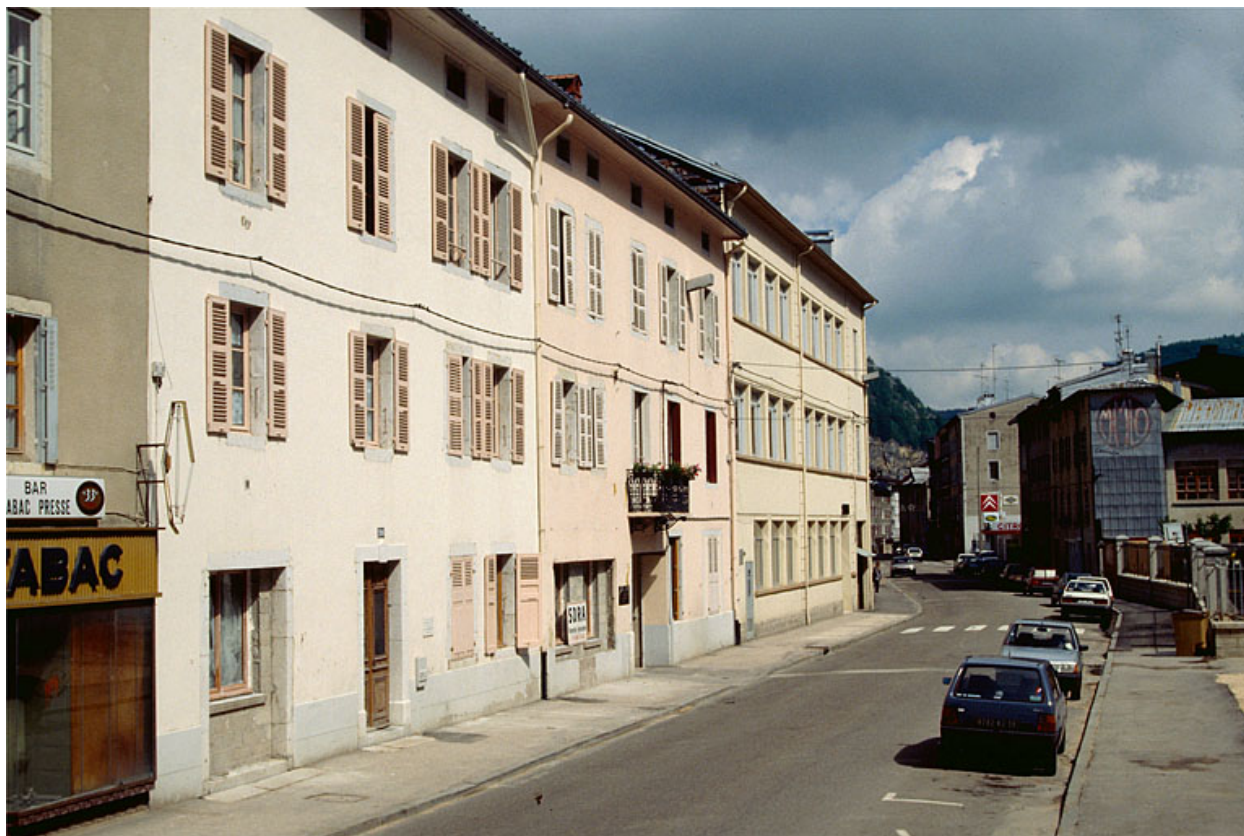
Façade antérieure des bâtiments sur rue.
