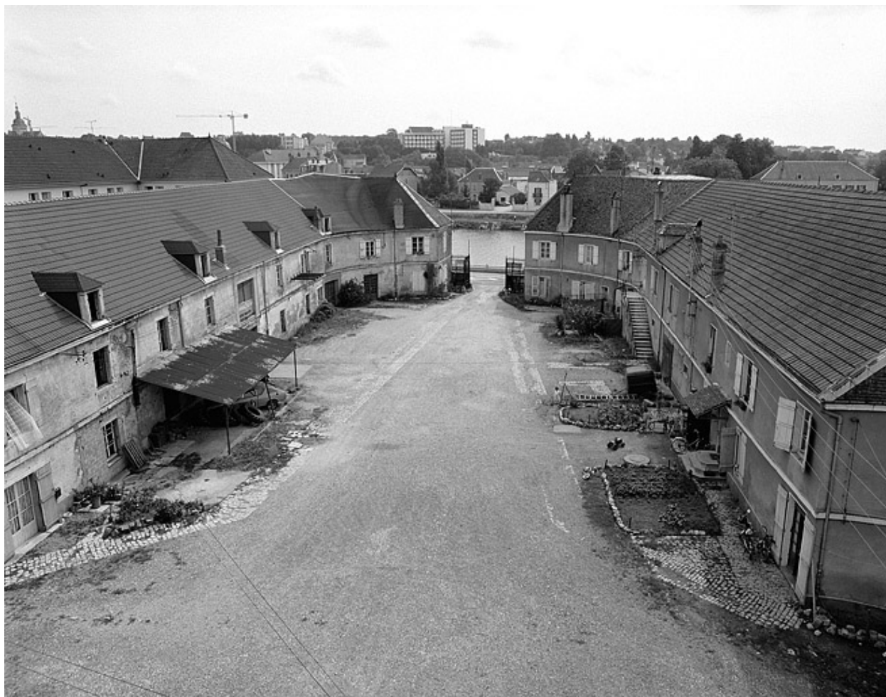
Vue d'ensemble des parties commerciales depuis l'habitation.
