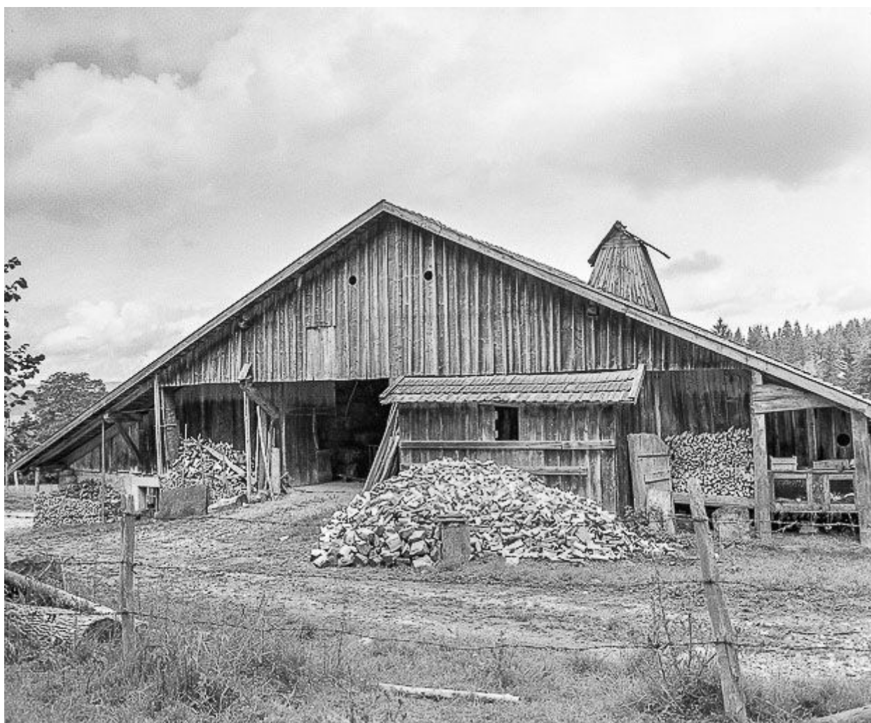
Ferme 2 : façade postérieure.
