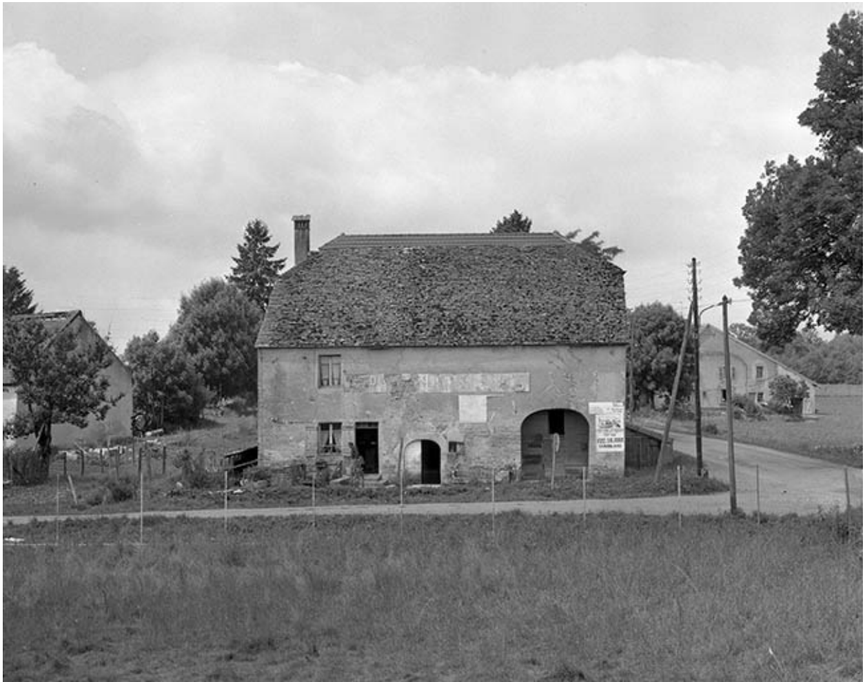
Façade antérieure, vue de face.
