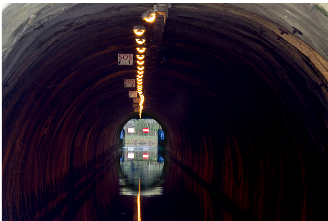
Le tunnel, vue intérieure.
