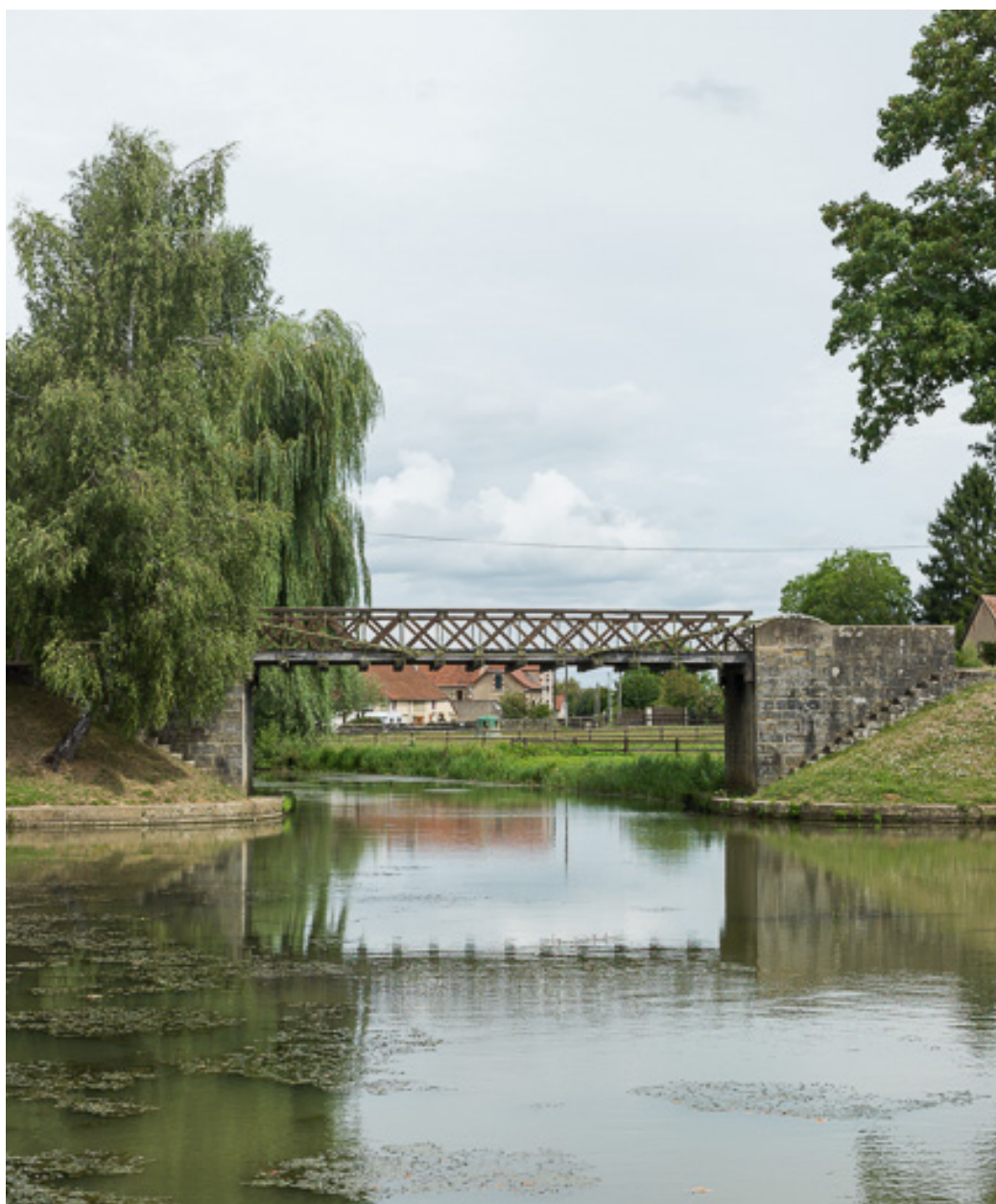
Vue d'ensemble de la passerelle.
