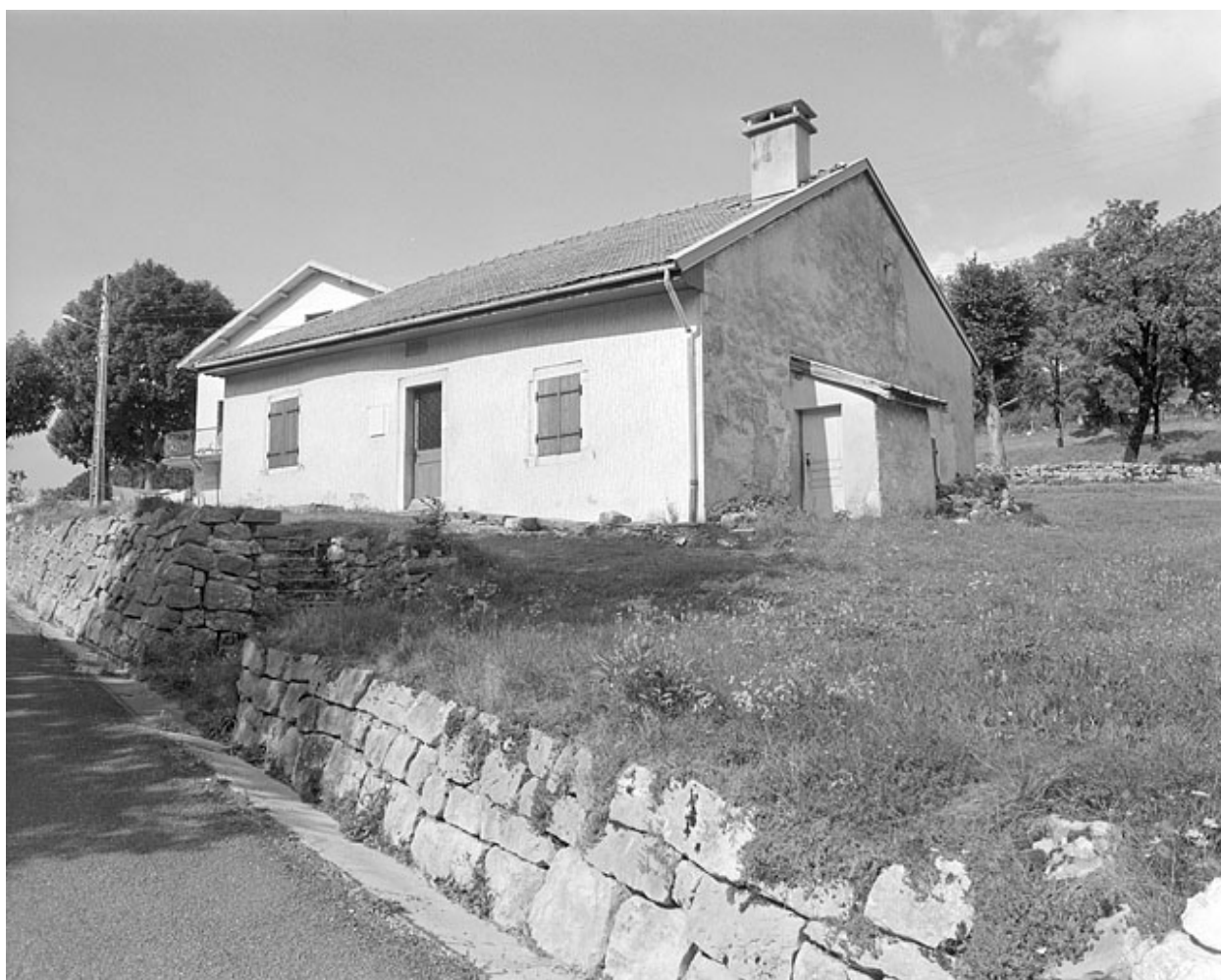
Façade antérieure et face droite.
