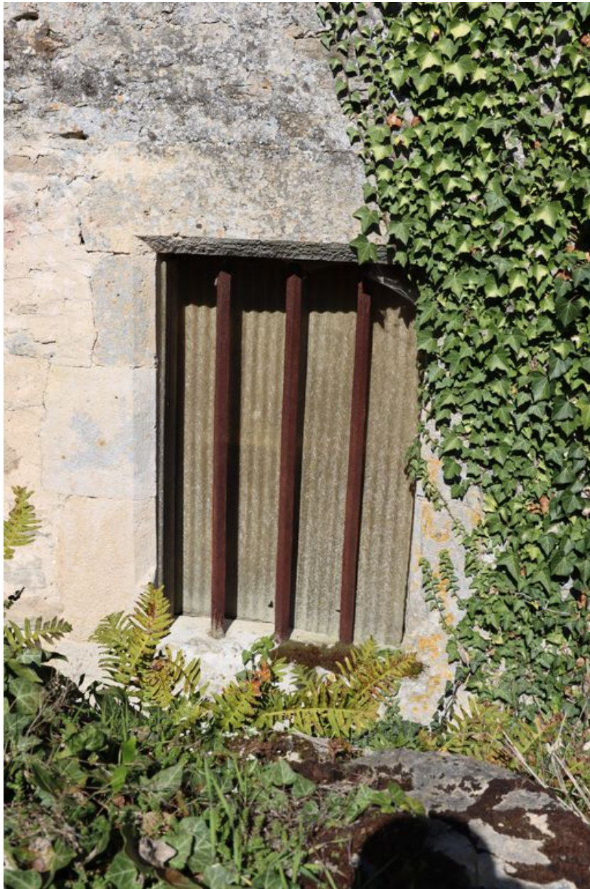
Détail d'une fenêtre de l'extension sud.
