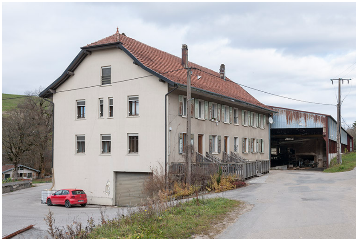
Bâtiment des logements et du bureau.
