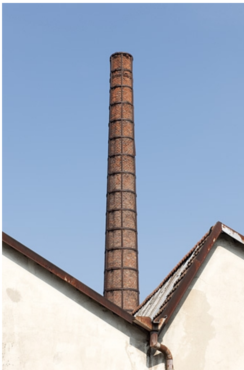
Sheds et cheminée de l'atelier de laitonnerie.
