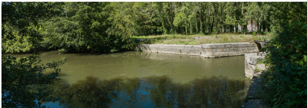
Vue du barrage.
