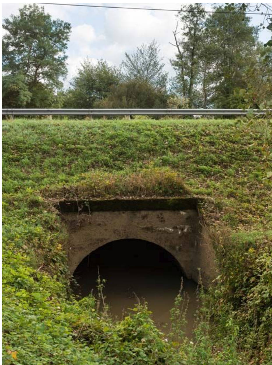
Vue de l'aqueduc.
