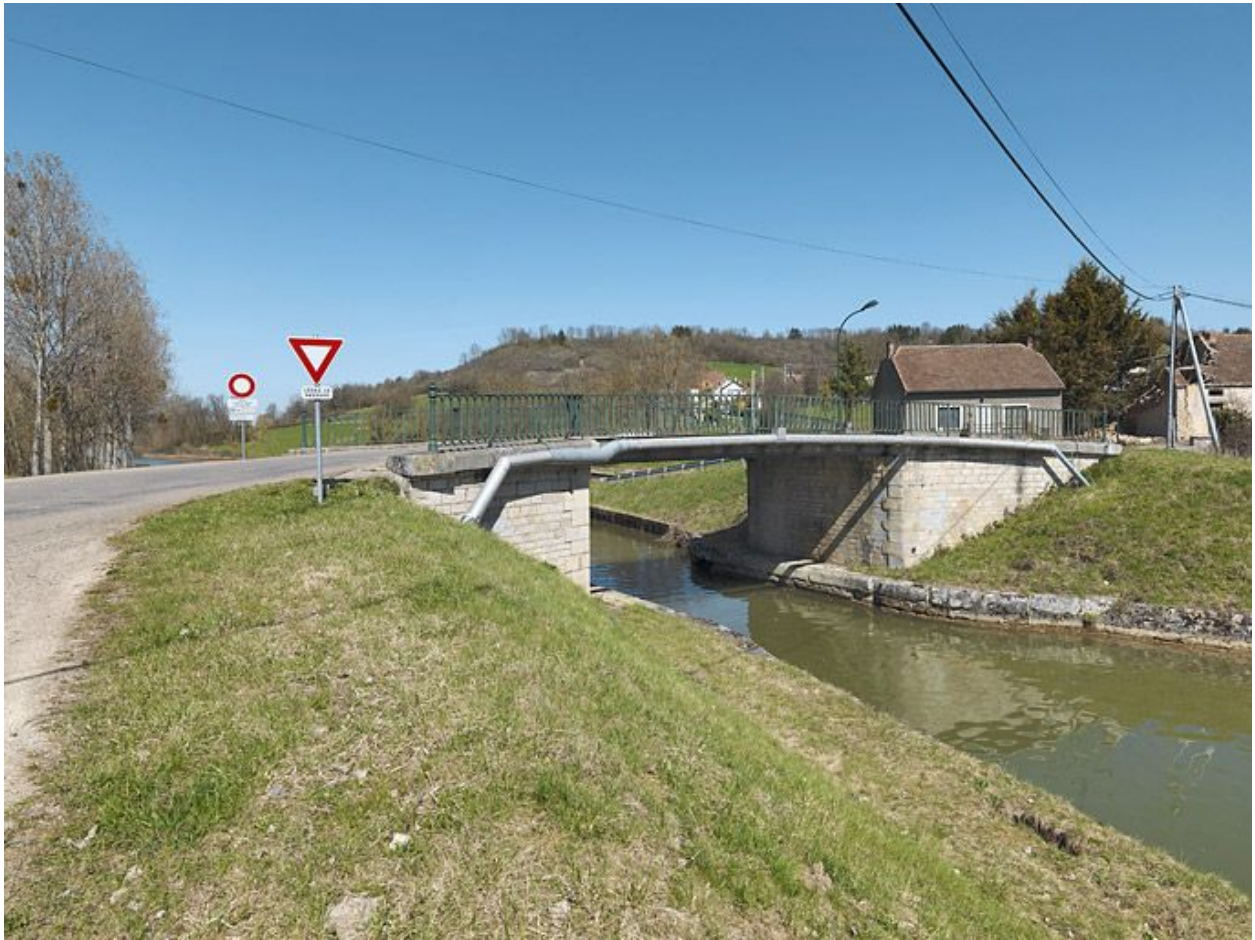
Pont routier isolé de Braux.
