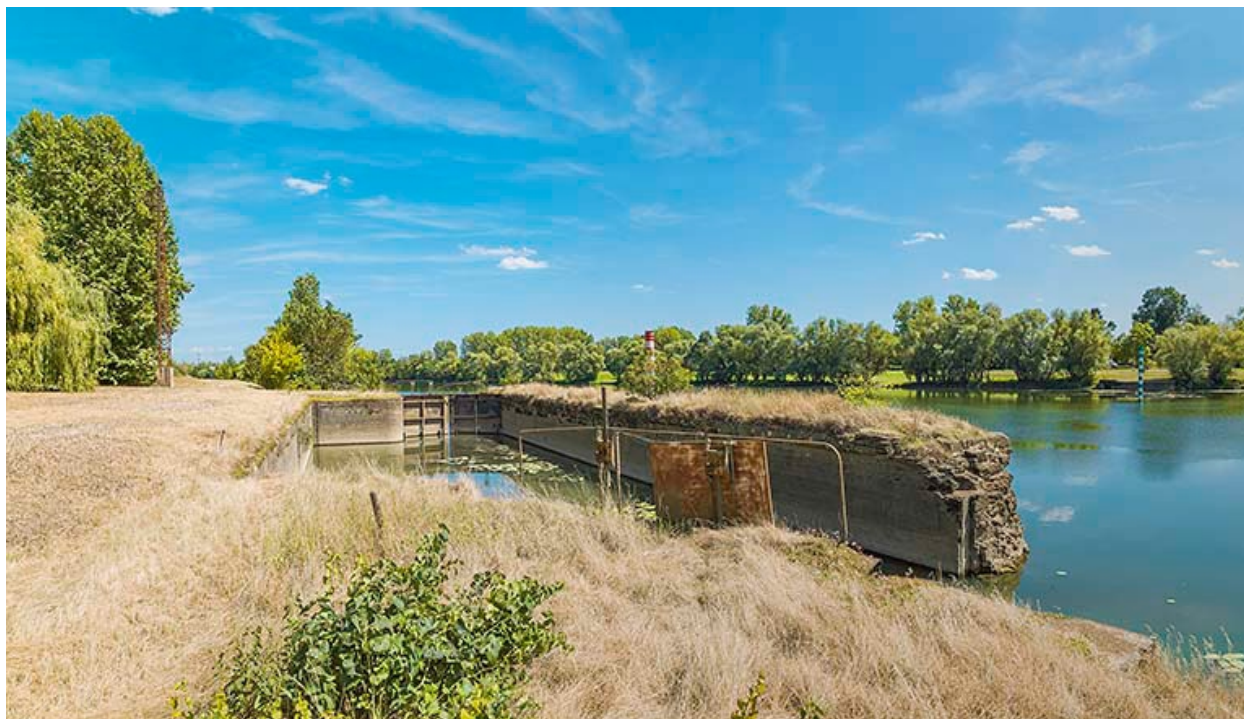
Le sas de l'ancienne écluse de Verdun.
