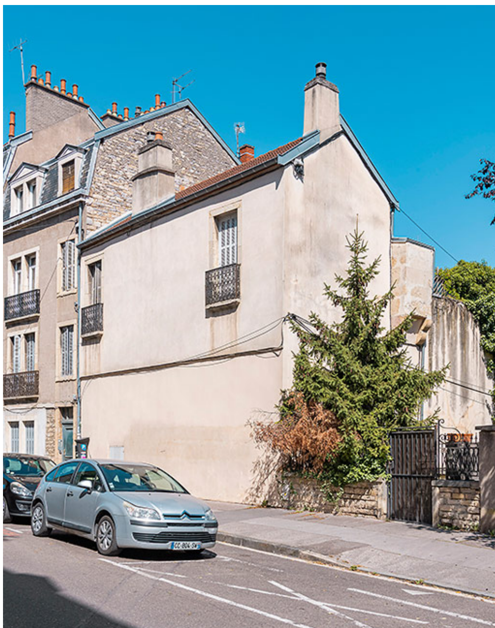
Bâtiment conservant une bretèche, rue Berlier.
