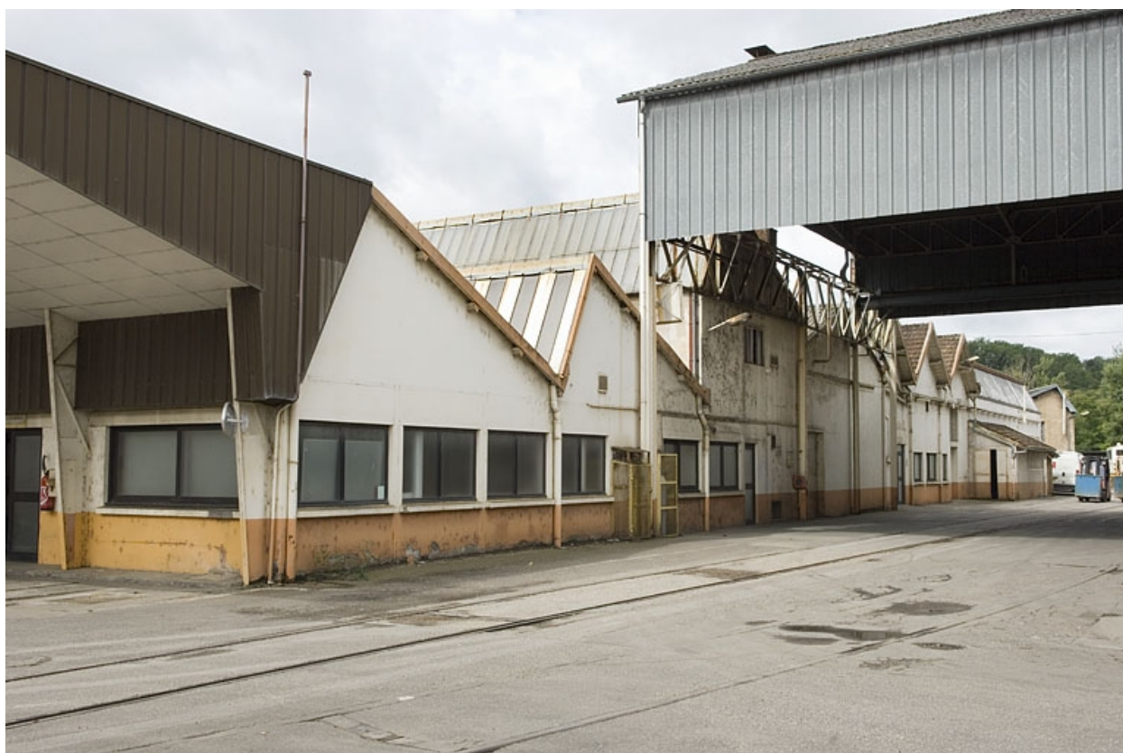
Façades nord des ateliers de fabrication.
