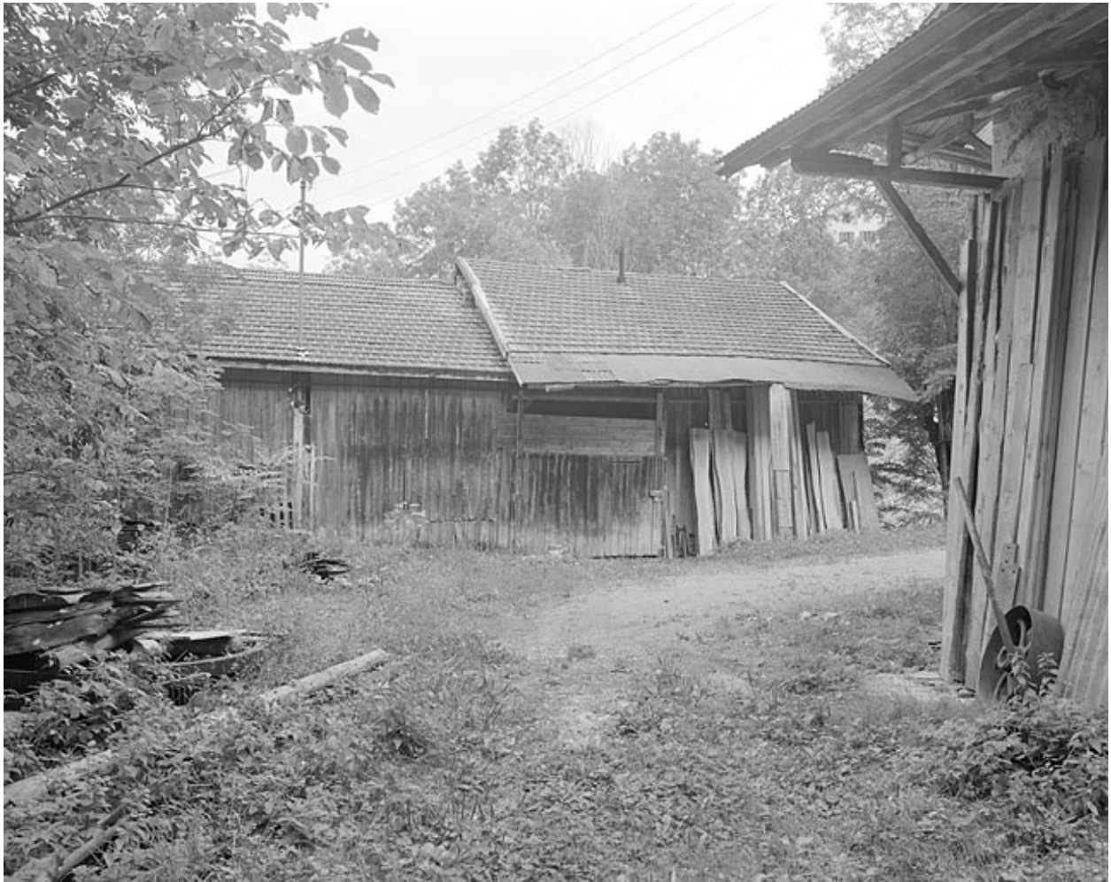
Façade antérieure de la scierie.
