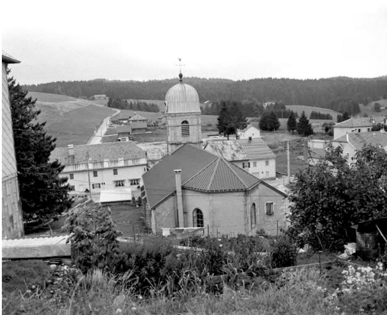
Extérieur : l'abside vue de face.
