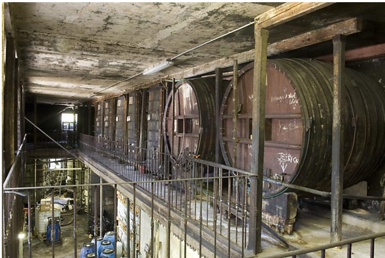
Etage de la cuverie (partie est).
