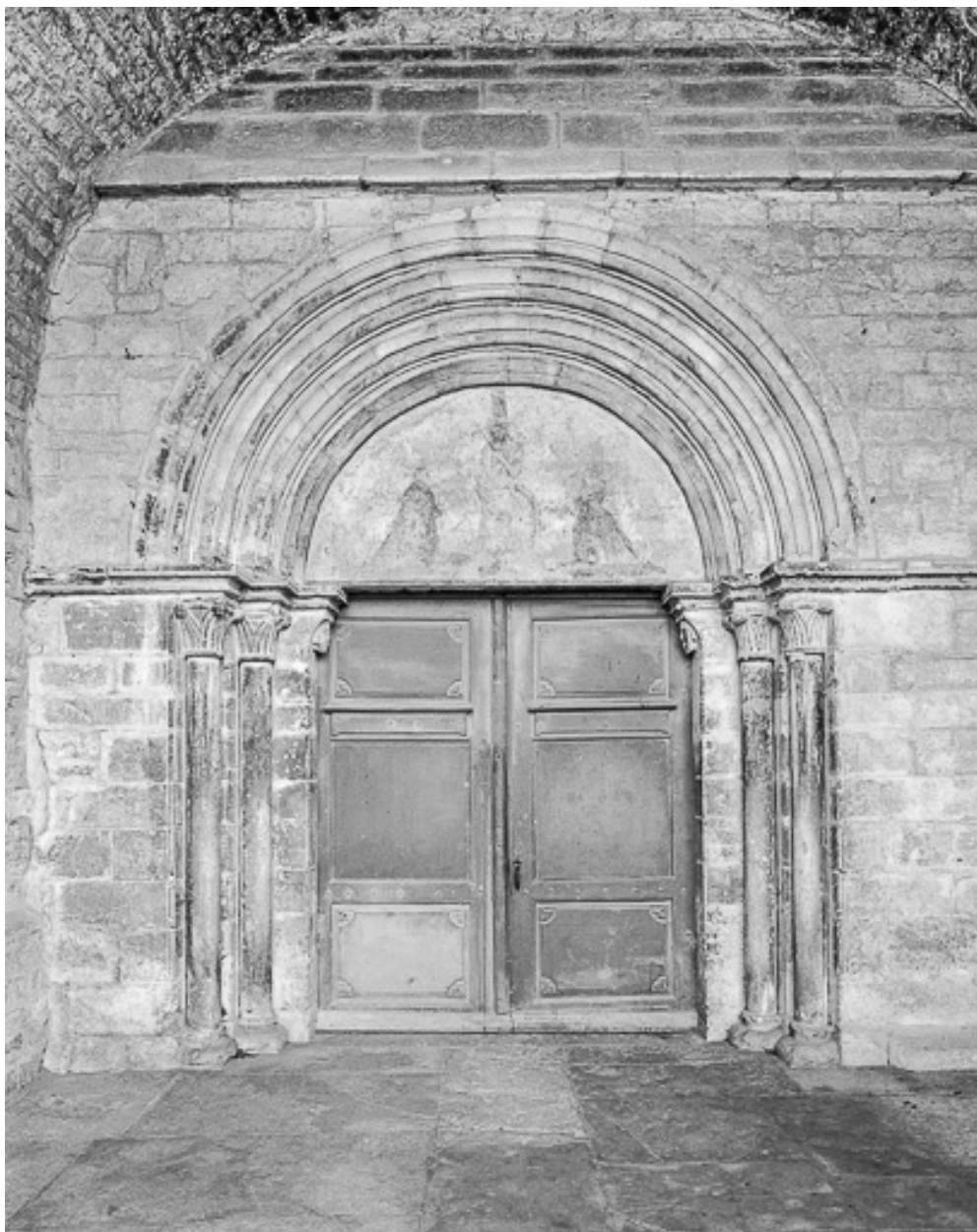
Exérieur : portail ouest.
