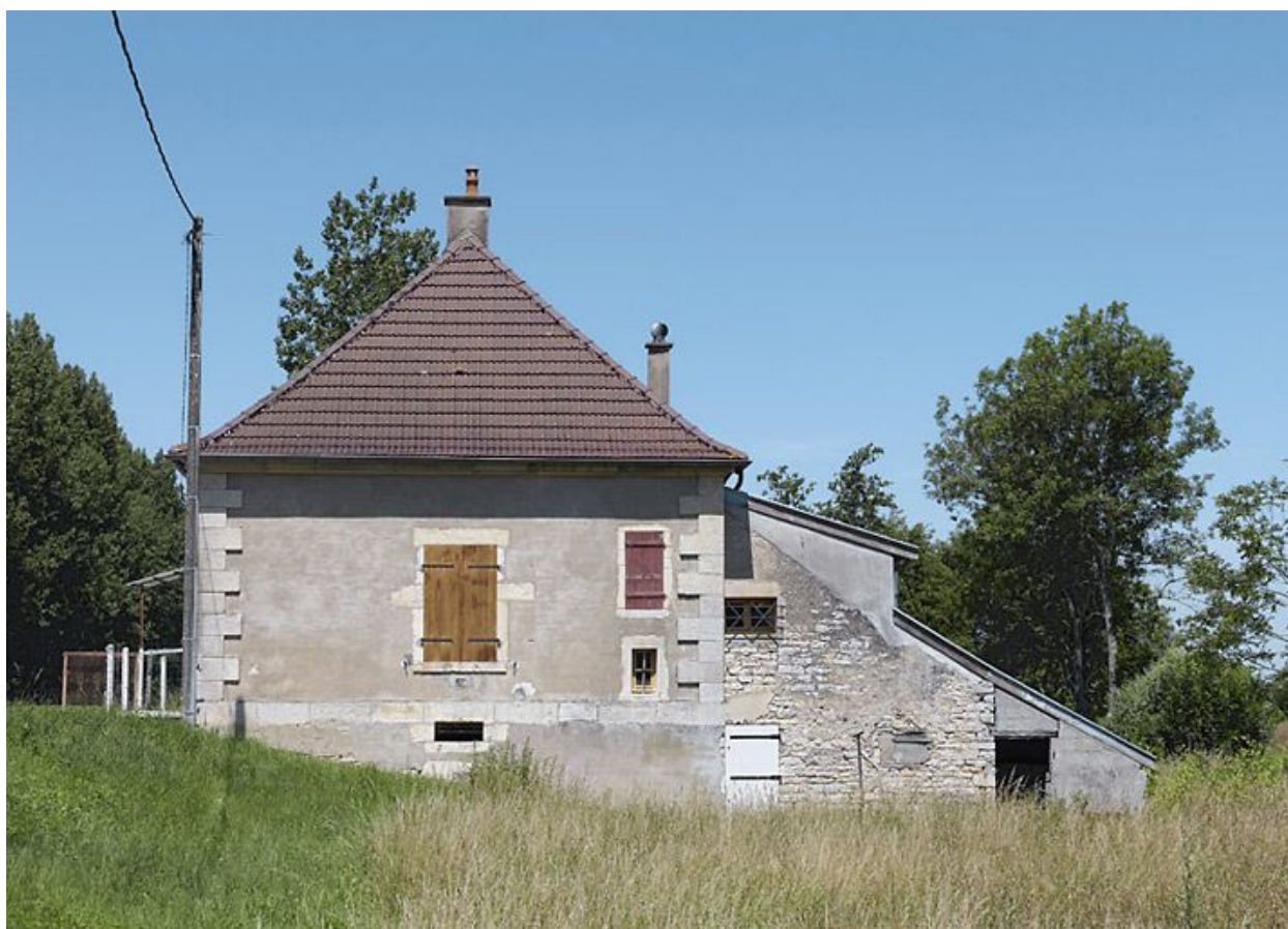
Maison éclusière vue de côté.
