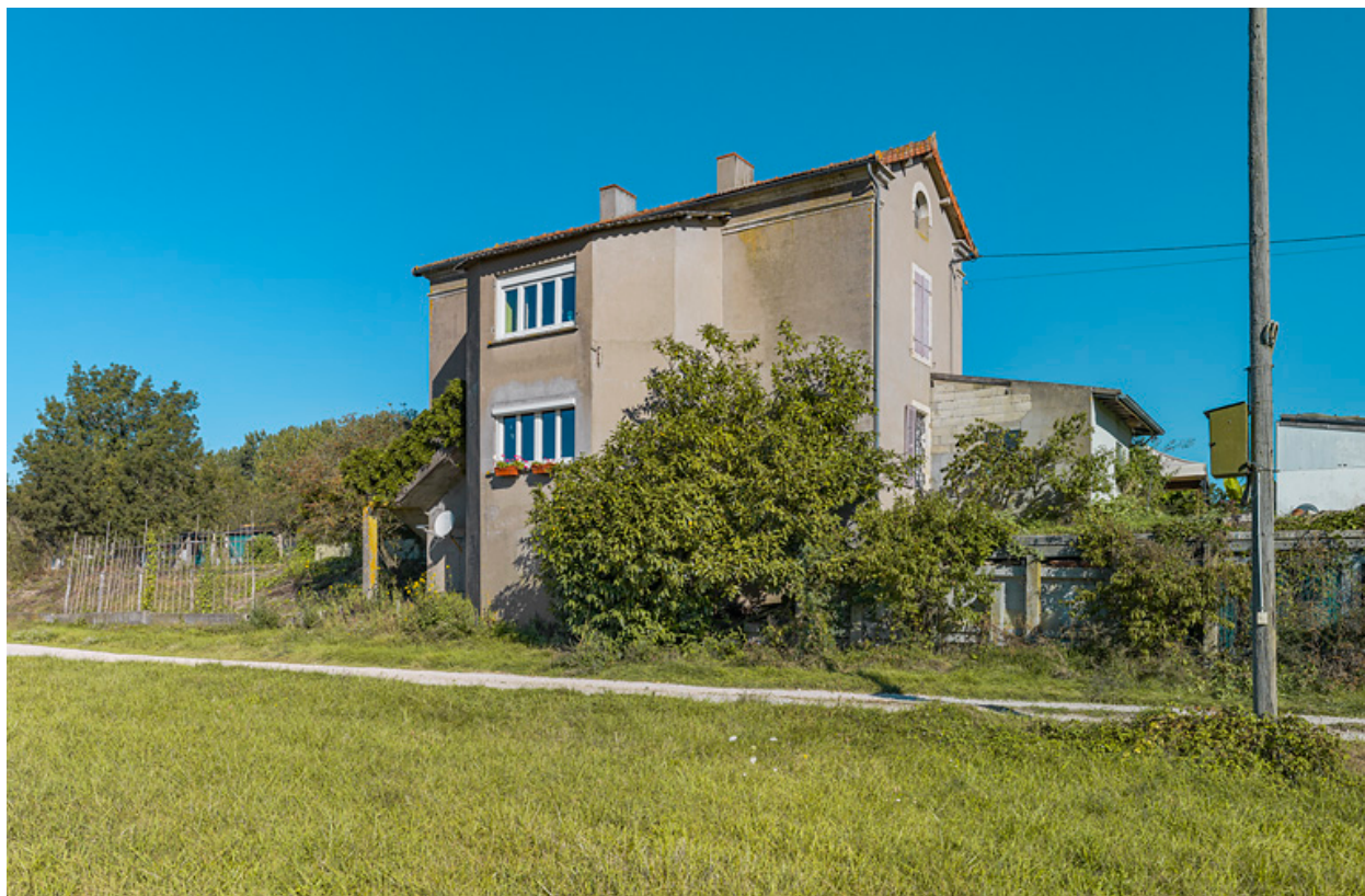
Façade arrière avec l'ajout d'un avant-corps central.
