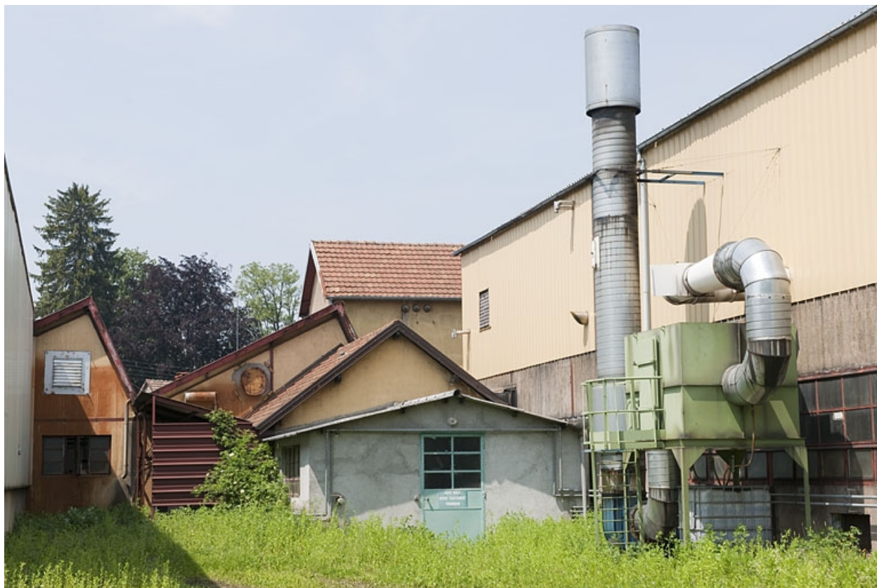
Façades postérieures de bâtiments industriels.
