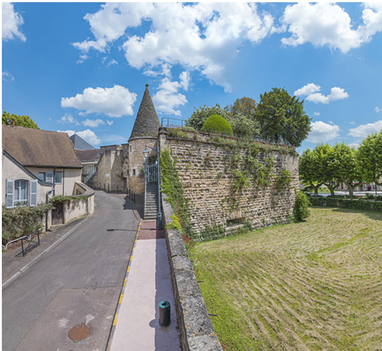
La tour, vue depuis celle des Bouchers.
