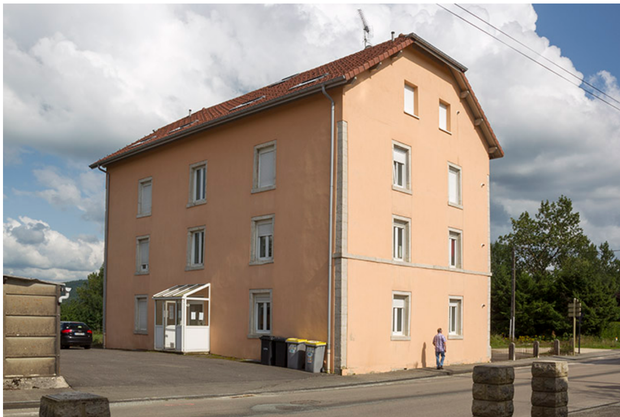
Façades antérieure et latérale droite.
