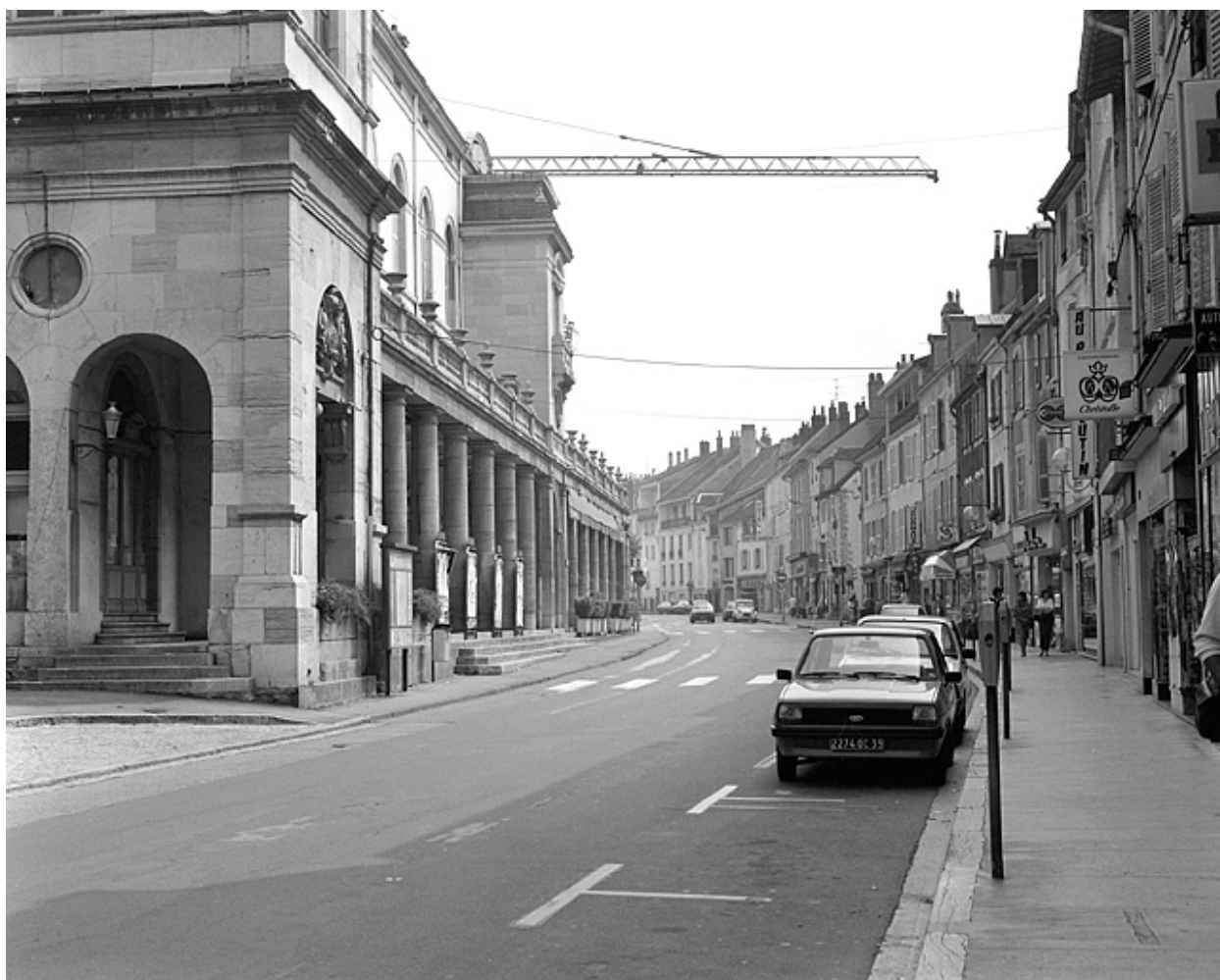
Façade latérale droite.
