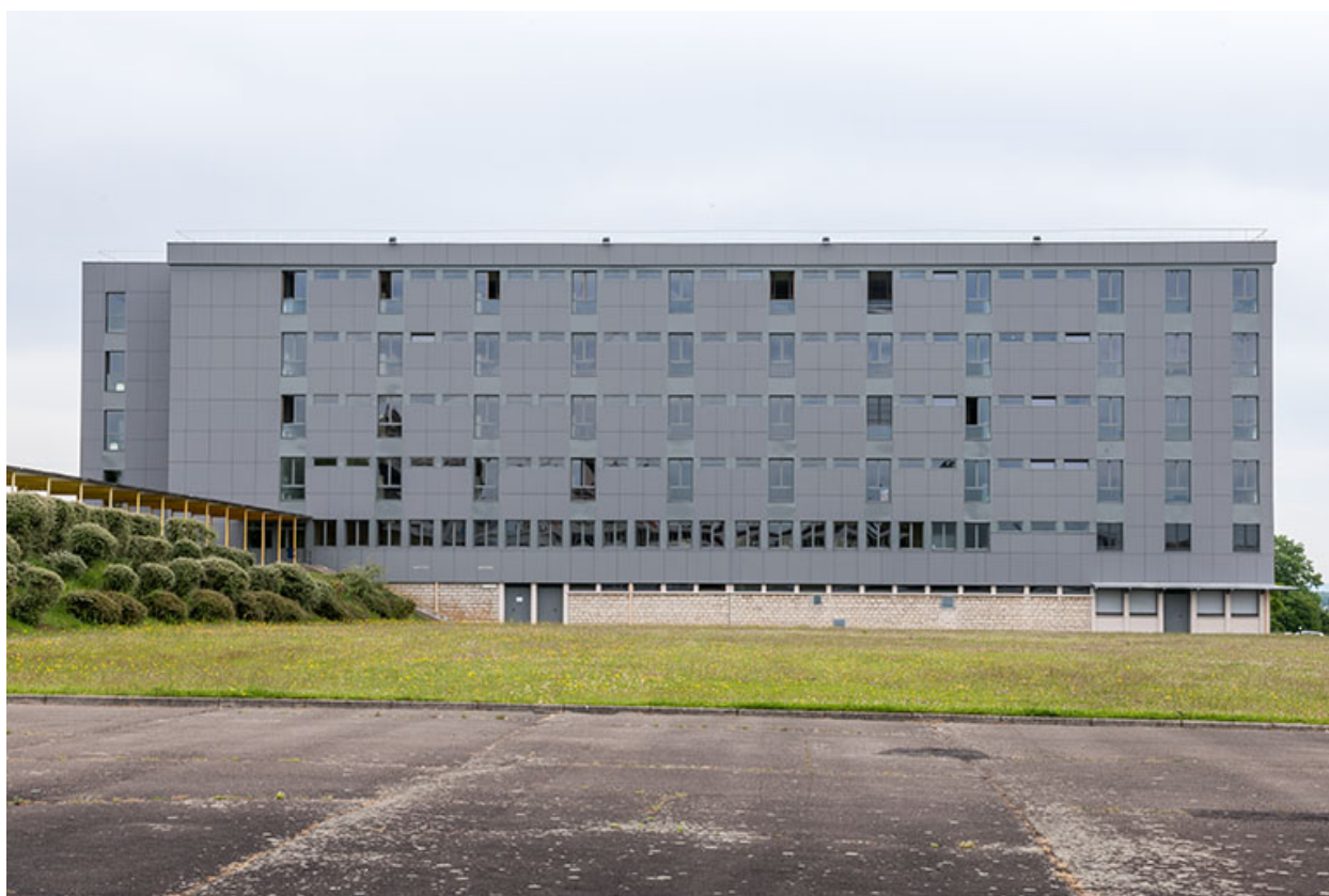
Internat : façade antérieure.
