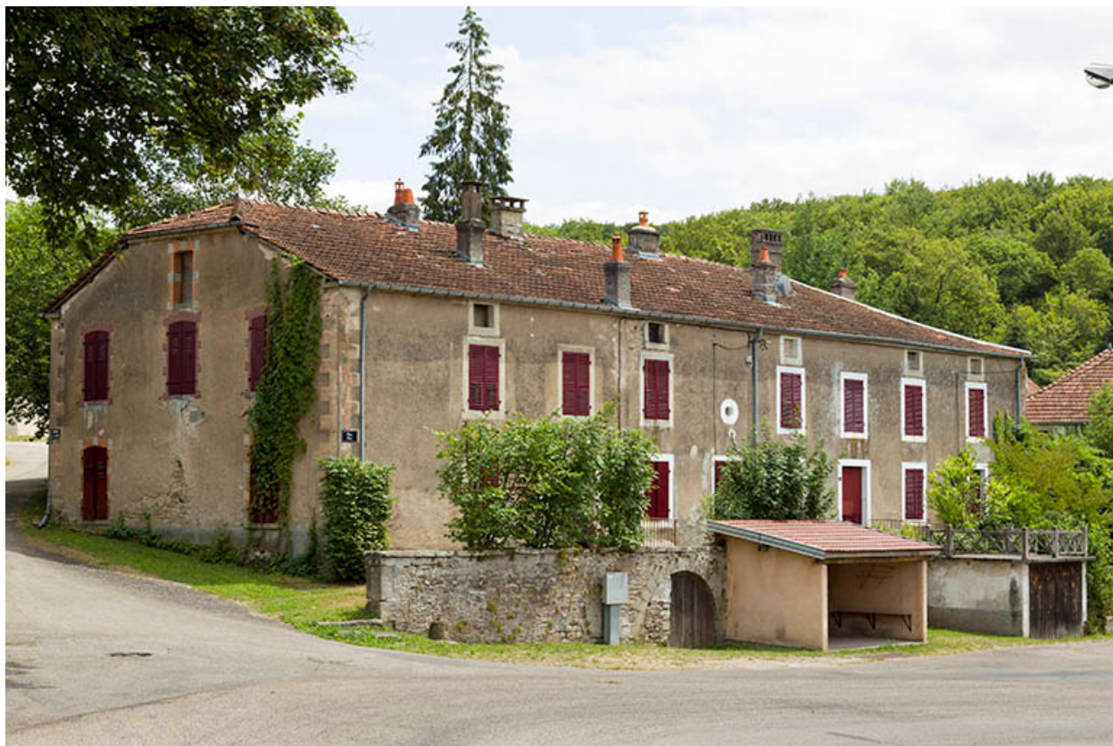
Logements d'ouvriers, place Dieu.
