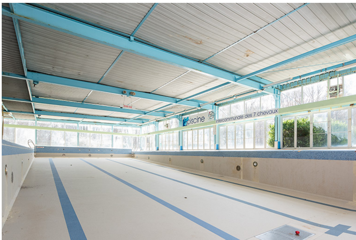
Le fond du bassin de la piscine, depuis l'angle nord-est.
