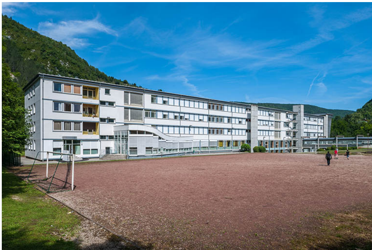
Internat : façade Est, terrain de football.
