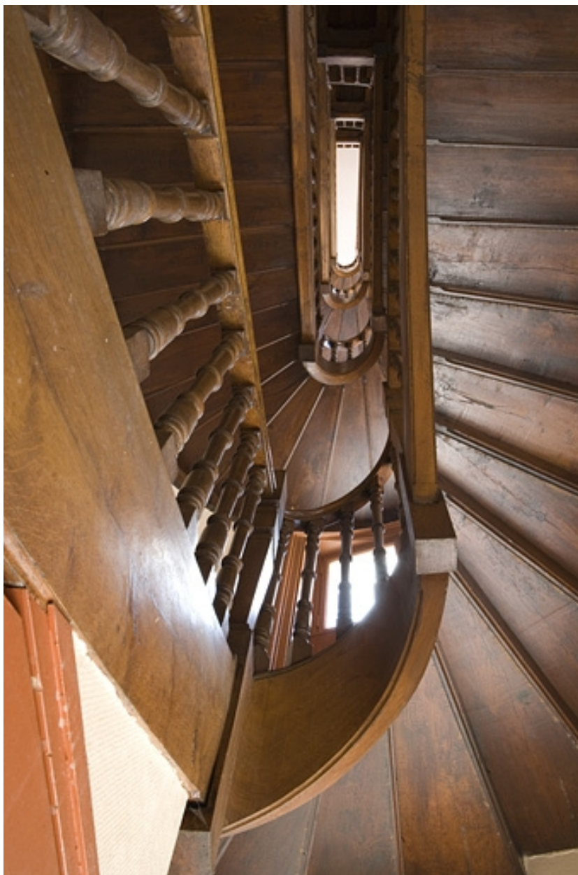
Vue d'ensemble de l'escalier.
