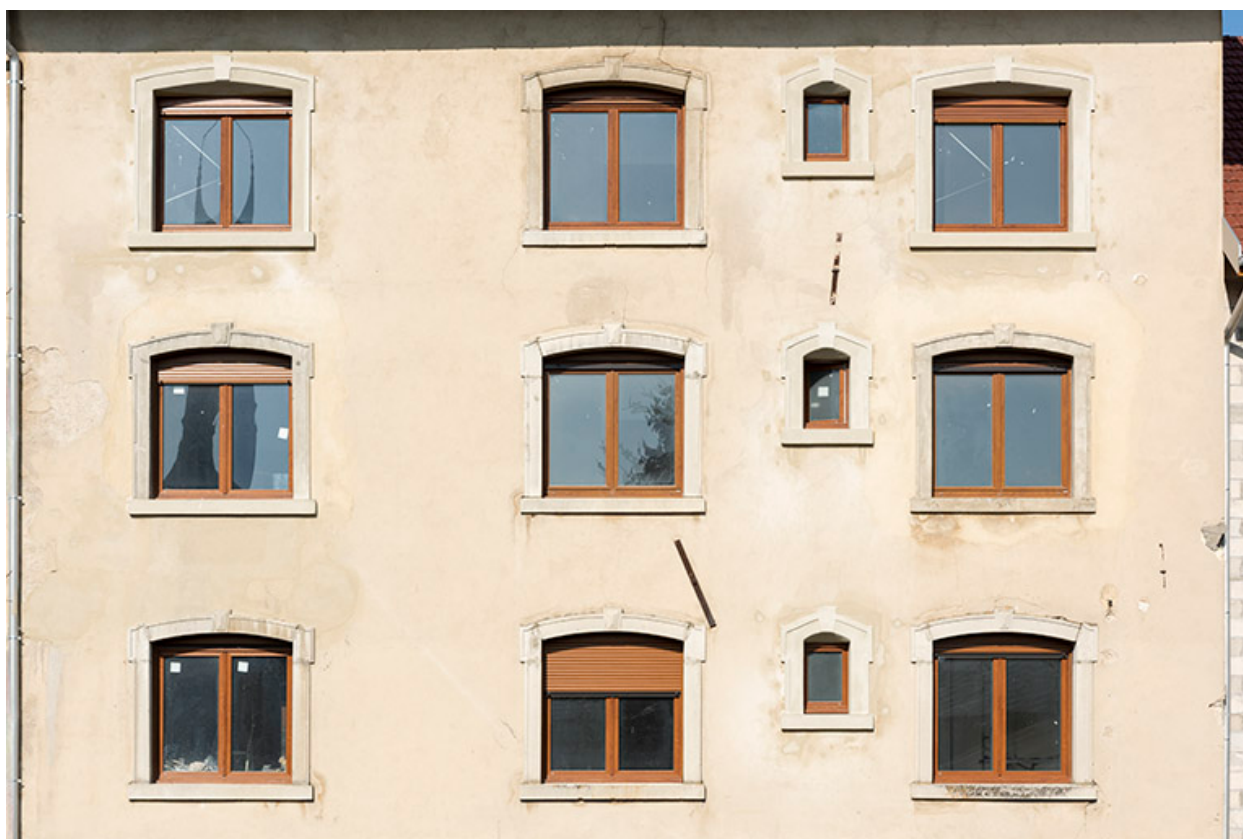
Façade postérieure : fenêtres.
