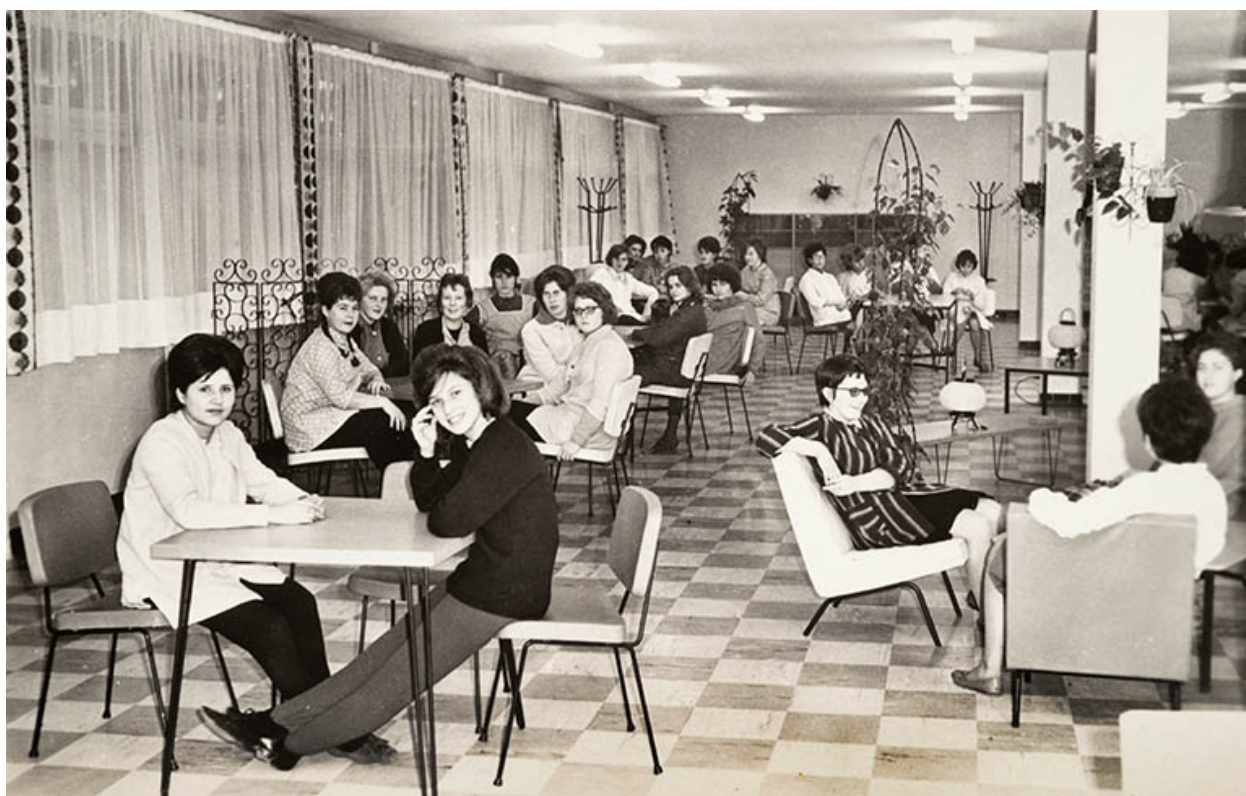
Vue intérieure du lycée durant les années 1960.
