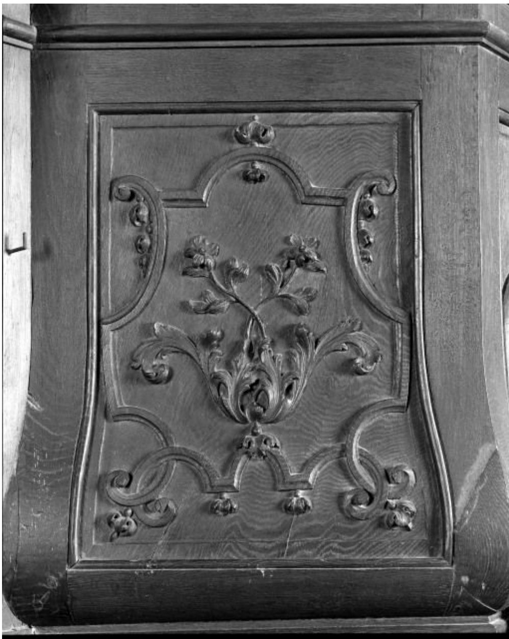
Détail de la cuve
