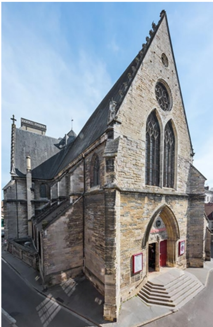
Façade occidentale, de trois quarts gauche.
