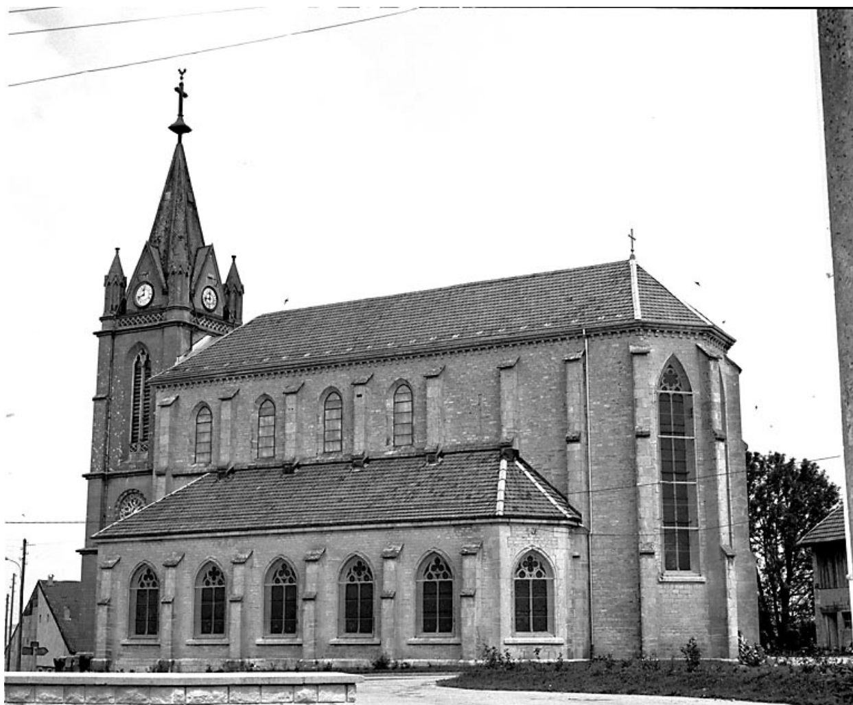
Façade latérale sud.
