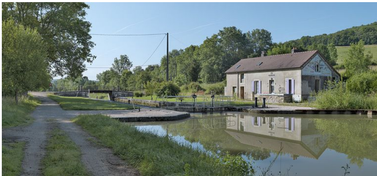
Site d'écluse vu d'amont.
