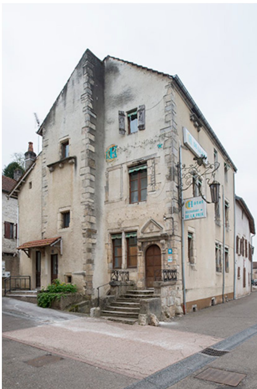
Vue générale depuis la rue Jean Bogé.
