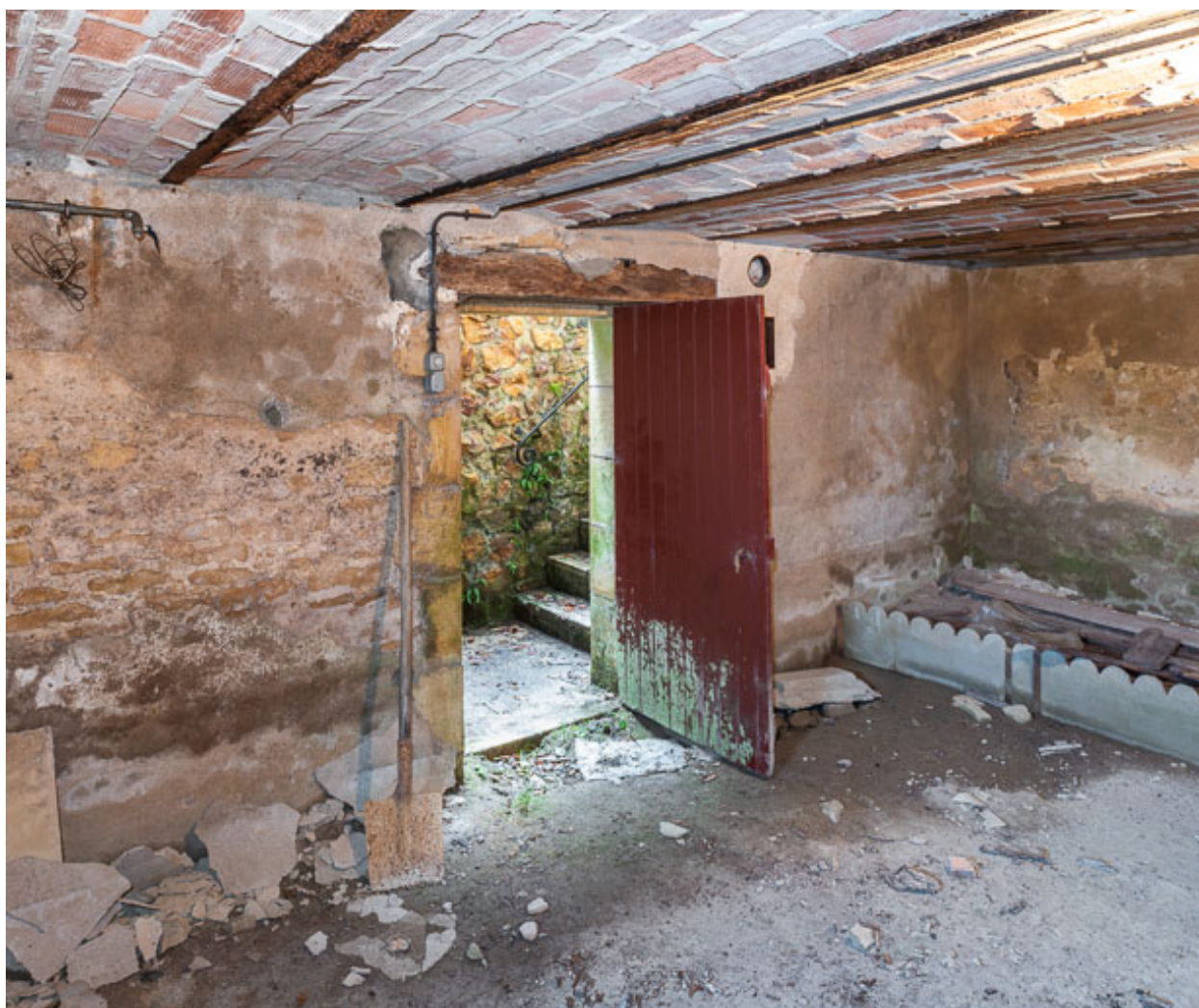
Vue intérieure de la cave.
