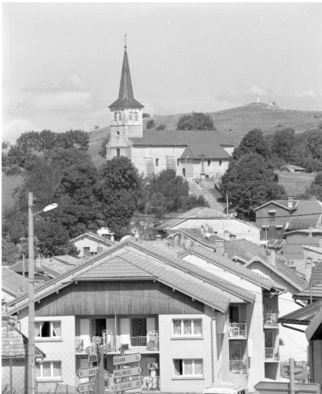
Vue de situation depuis le sud-ouest.
