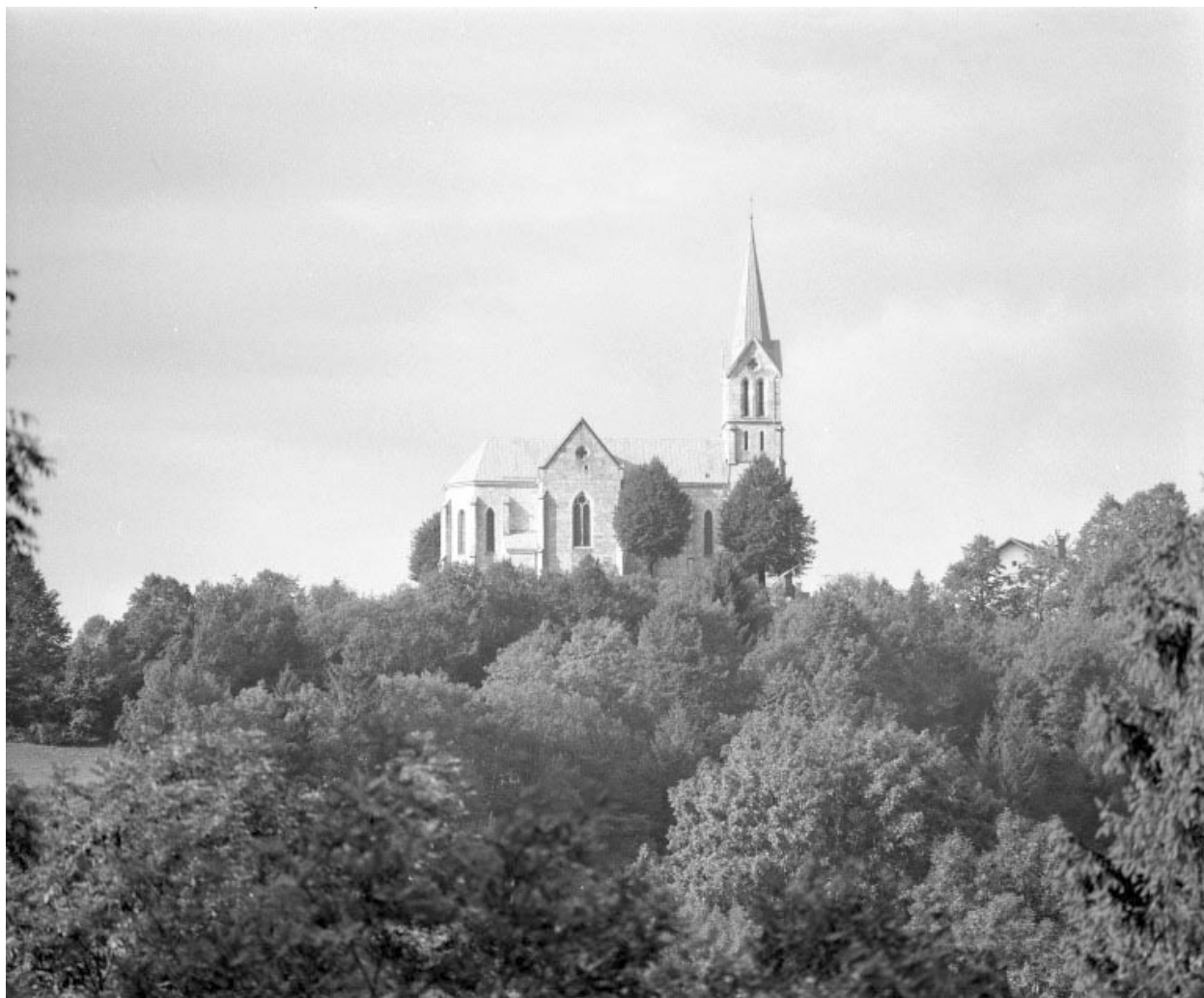
Extérieur : vue générale de la face nord.
