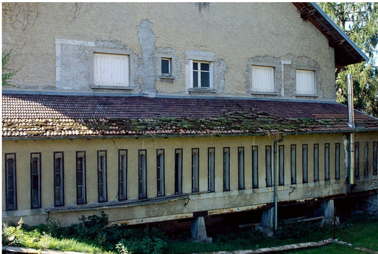
Ancienne chambre à lait en façade postérieure.
