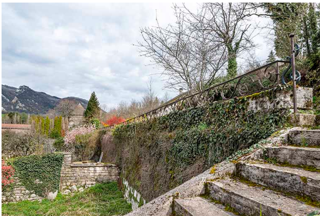
Terrasses supérieures, depuis le sud.
