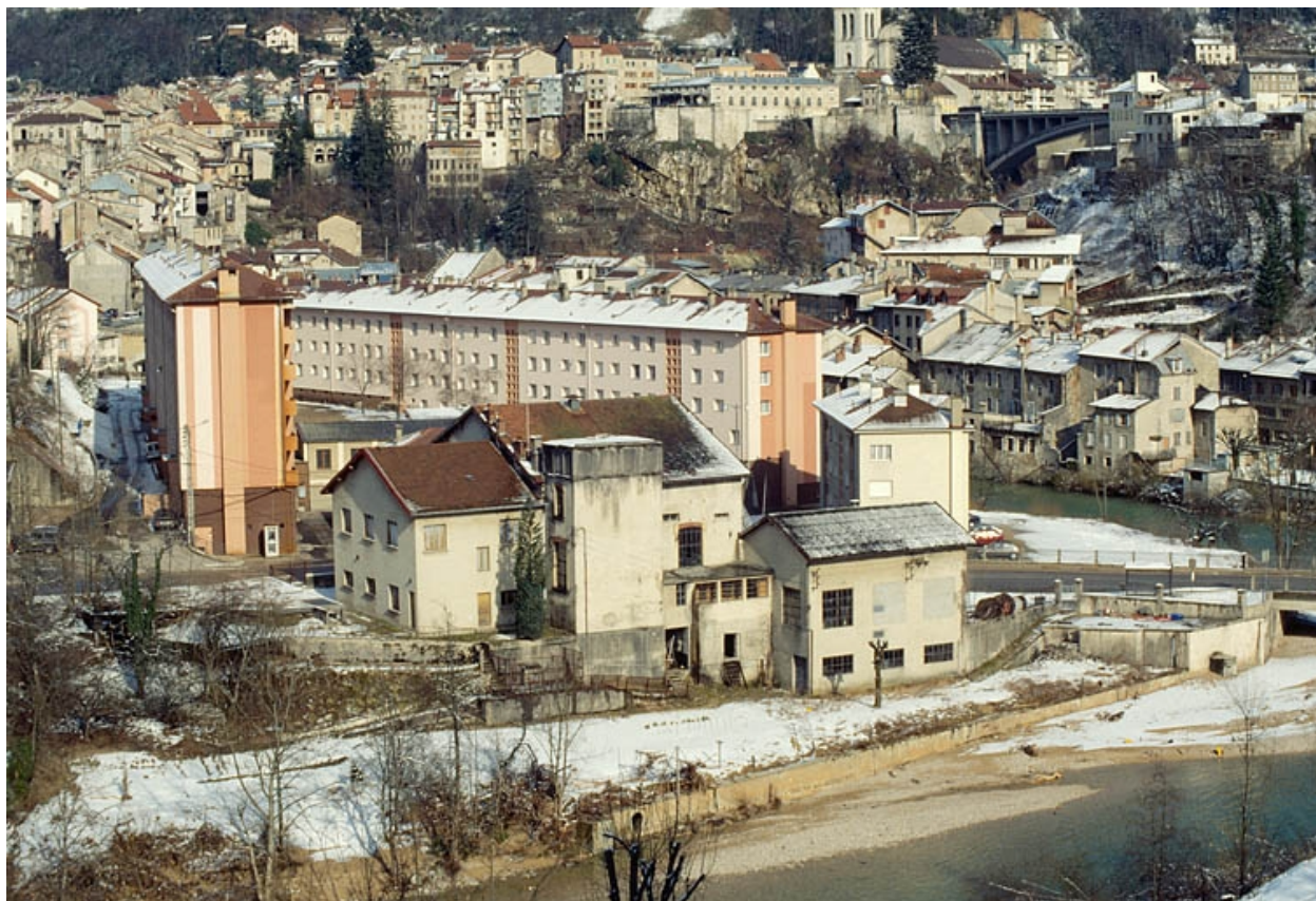
Vue d'ensemble rapprochée depuis l'ouest.
